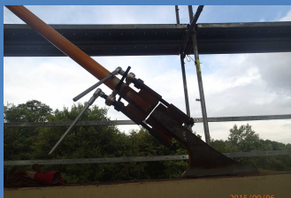
Obr.3: Přípravek pro vnesení předpětí do táhla
