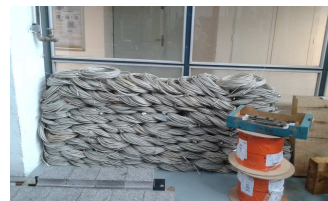
Obr.6: Kabeláž připravená pro měření
